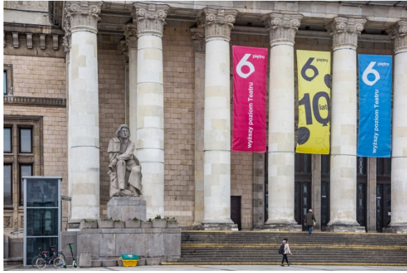
zdj.7 Wejście główne i platforma dźwigowa fot.Igor Godlewski
